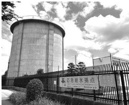
▲三鷹上連雀給水所は武蔵境通り沿いに。
